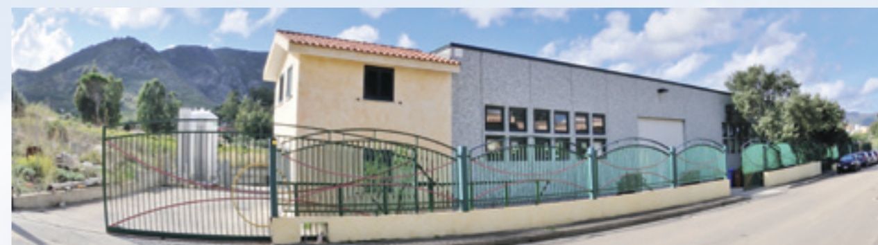
Stabilimento componenti industriali e lavorazione
